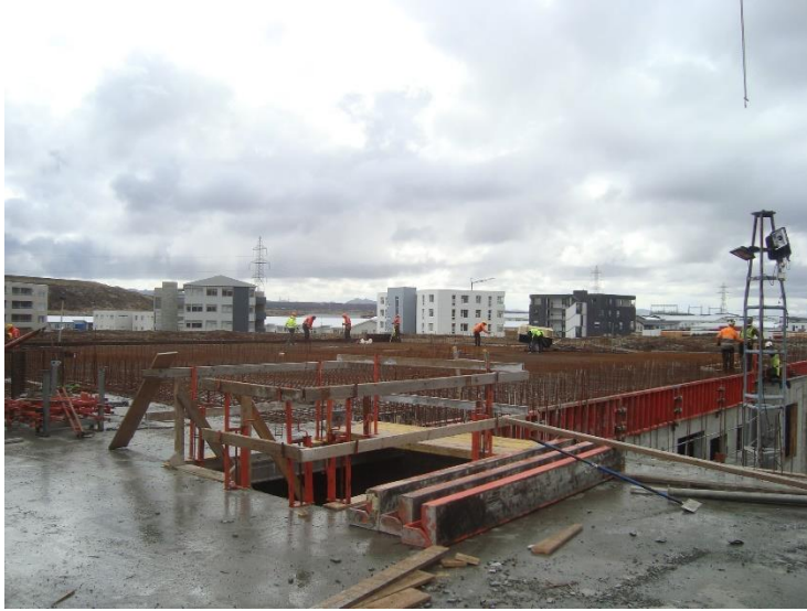
Hús A, járnbinding plötu yfir 1.h. .
