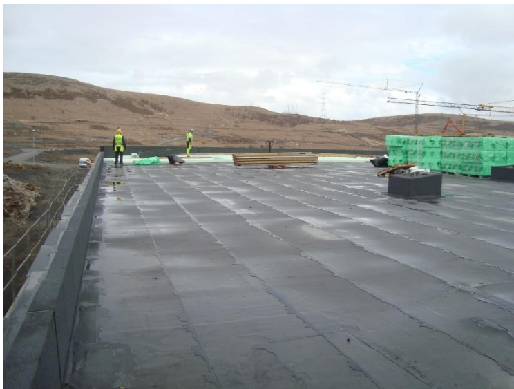
Hús C, unnið við einangrun þaks.
