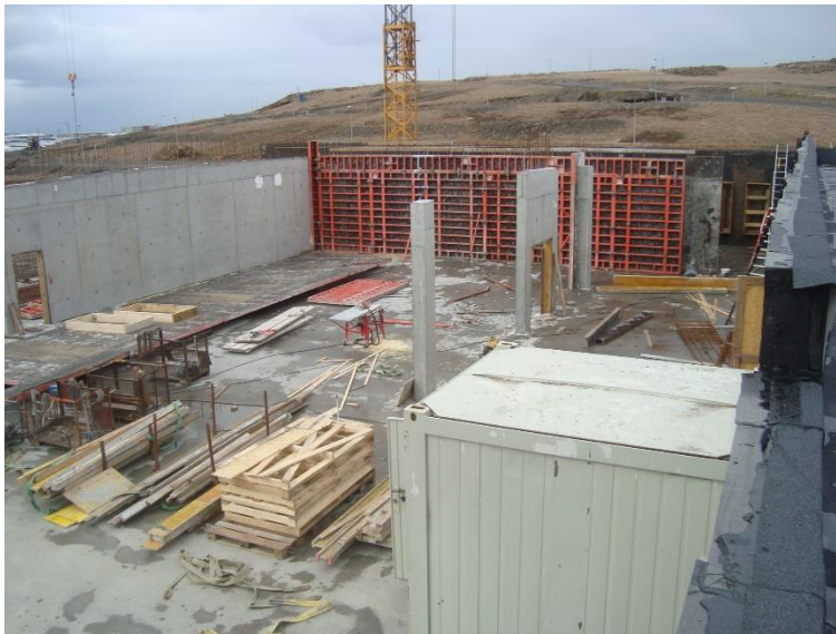
Hús B, unnið við uppsteypu veggja 2h.
